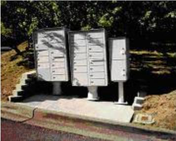
**CORRECT** - THE RETAINING WALL SHOWS HOW IMPORTANT IT IS TO INSTALL THE CBU AWAY FROM THE STREET.
