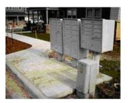
**CORRECT – N**OTE HOW MUCH CONCRETE WAS REQUIRED IN ORDER TO MEET LOCAL CODES.
